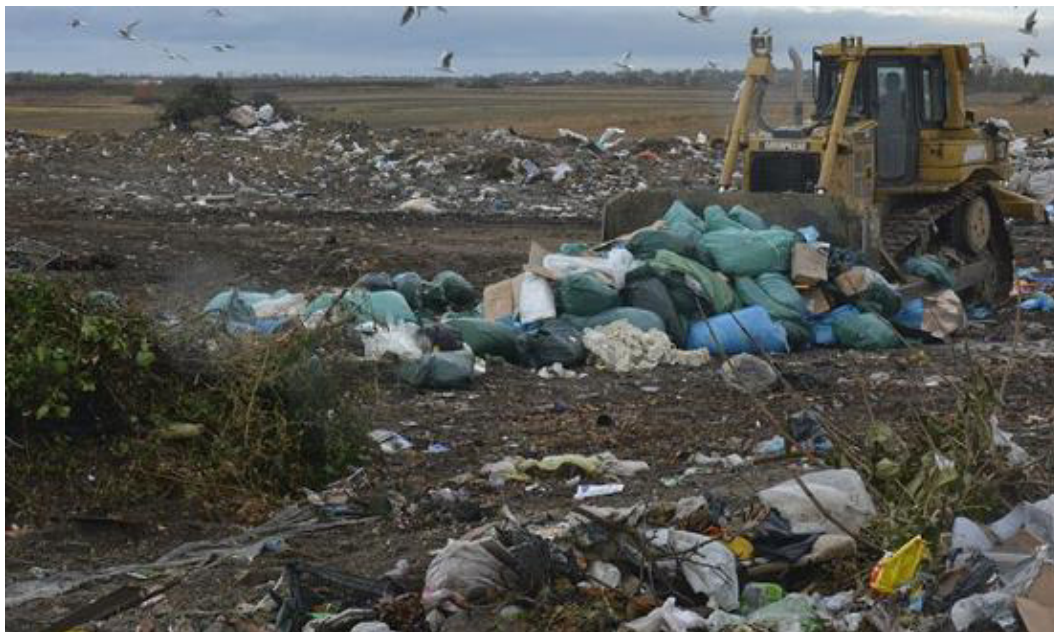
Слика 4.6-4. Механизација-булдожер на раду на телу депоније
