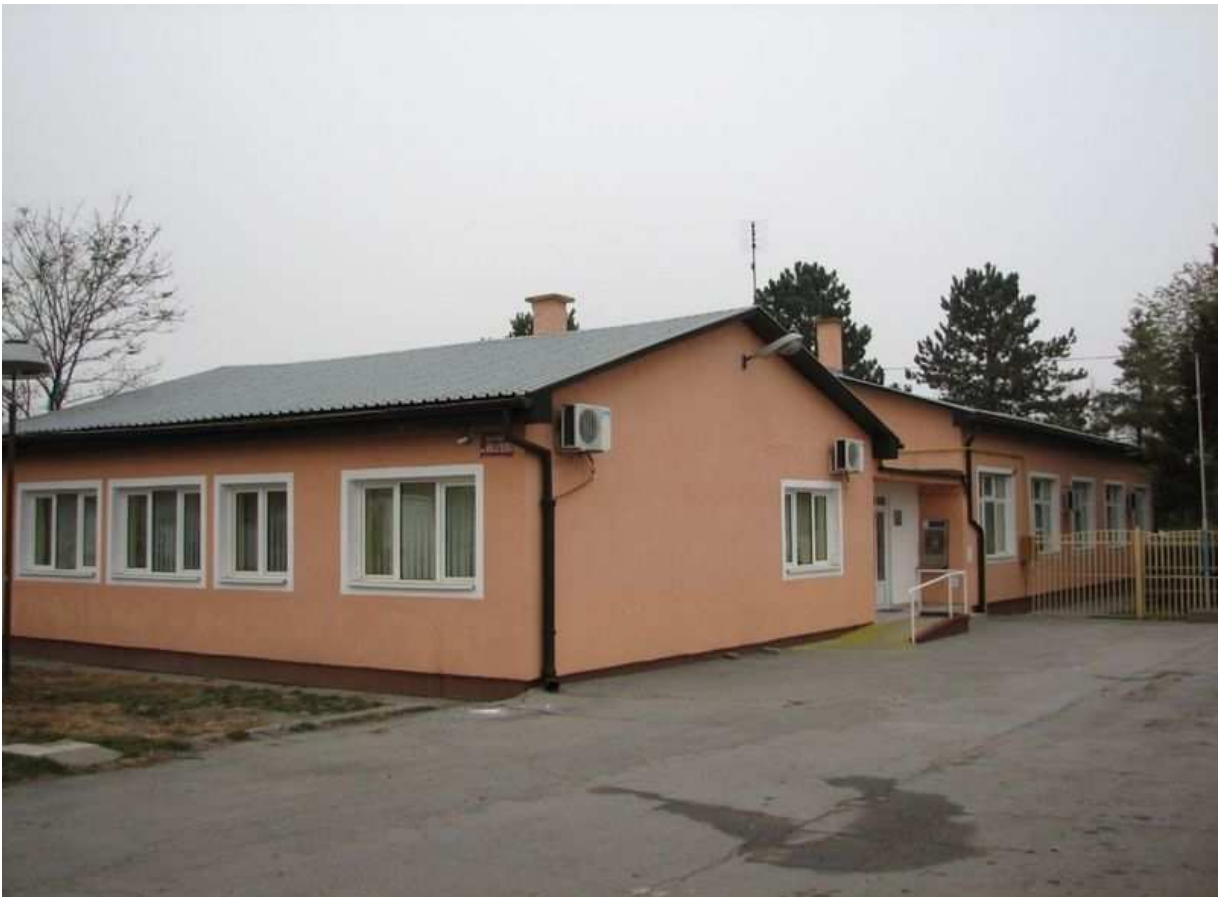
Садашњи изглед зграде месне заједнице
